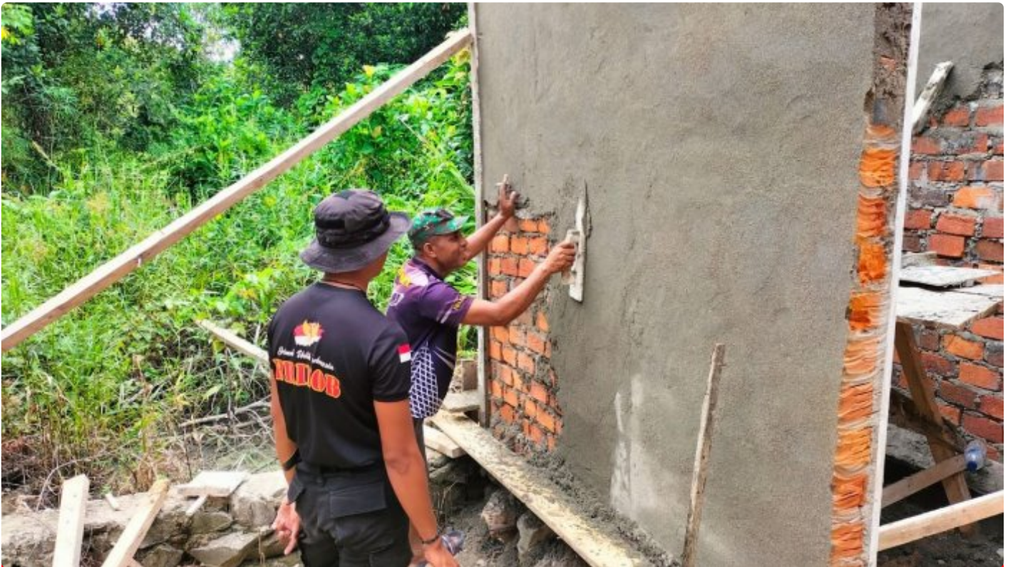
Satgas TMMD Ke- 118 Wiltas Kodim 0910/Malinau Plester Dinding Pembangunan MCK Gereja
