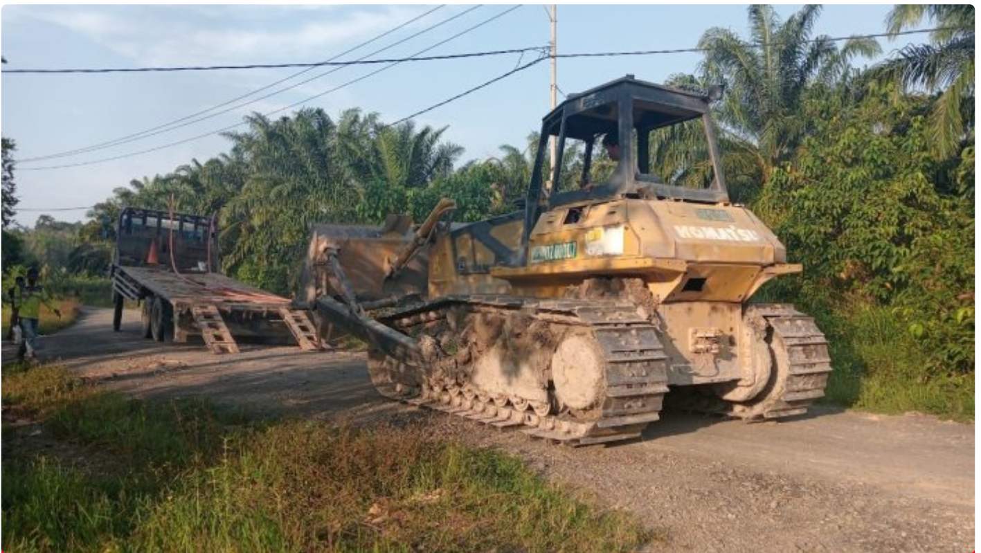
Percepat Pembukaan Badan Jalan Satgas TMMD Ke- 118 Turunkan Bulldozer
