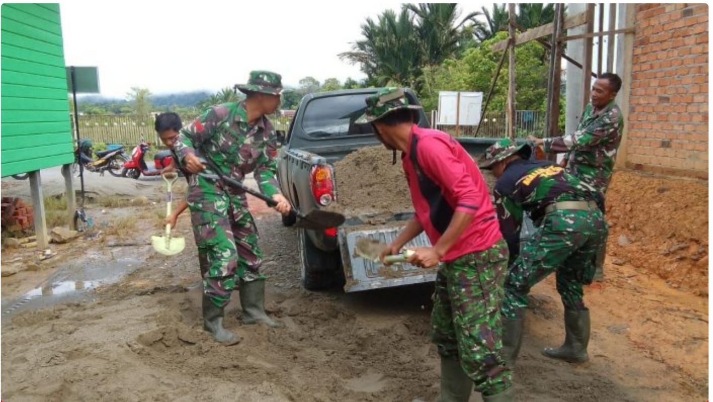
Gunakan Mobil Dinas, Satgas TMMMD 118 Langsir Pasir Di Sasaran Semenisasi Jalan
